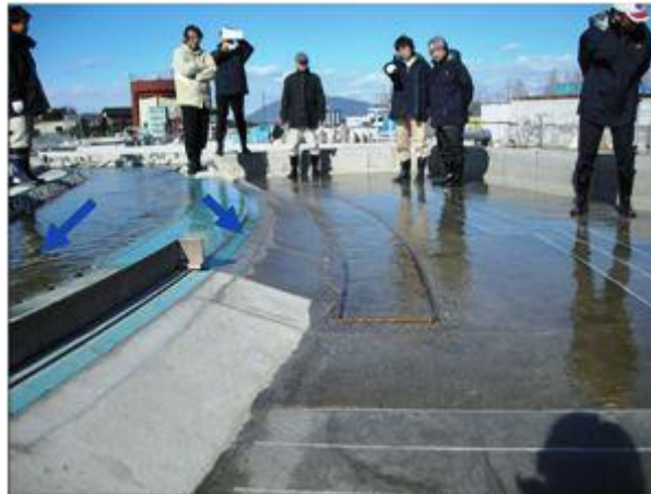
写真-6 立会い確認検査状況
