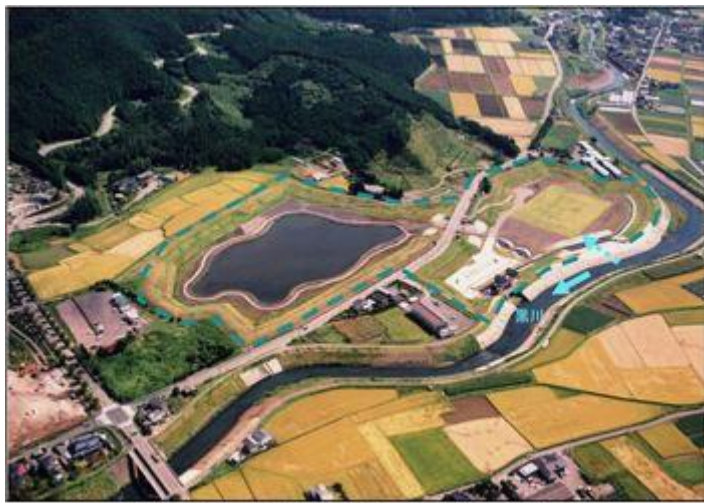
写真－2 内牧遊水地(平成6年完成)
