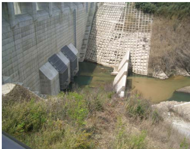
図-1 益田川ダム流木止めのコンクリート壁
