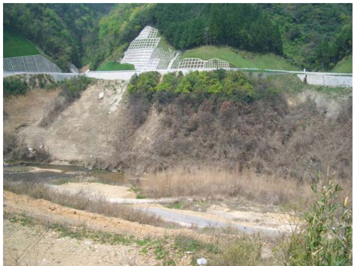
図-5 益田川ダムの試験湛水により枯死した植生
