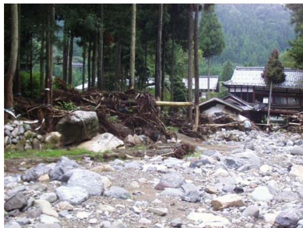
図-4 足羽川土石流災害（2004年）
