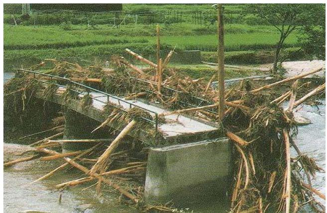
写真-4 橋梁に埋塞した大量の流木
