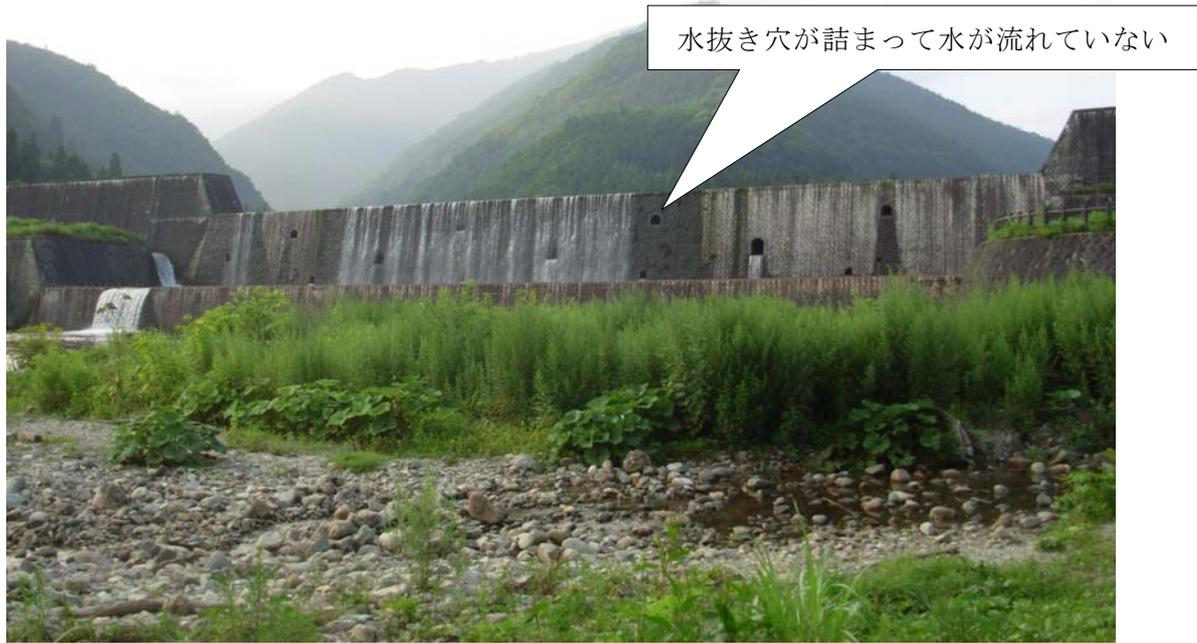
写真-2 水抜き穴が閉塞した砂防堰堤（山形最上白川）
