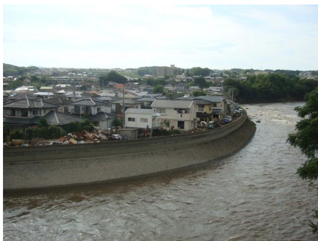
写真2 洪水がコンクリート堤防を乗り越え右岸のわん曲内岸側の住宅地を襲った
