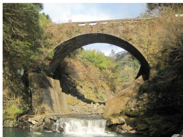
流失前の黒川橋(1900年完成) 2011年12月18日撮影
