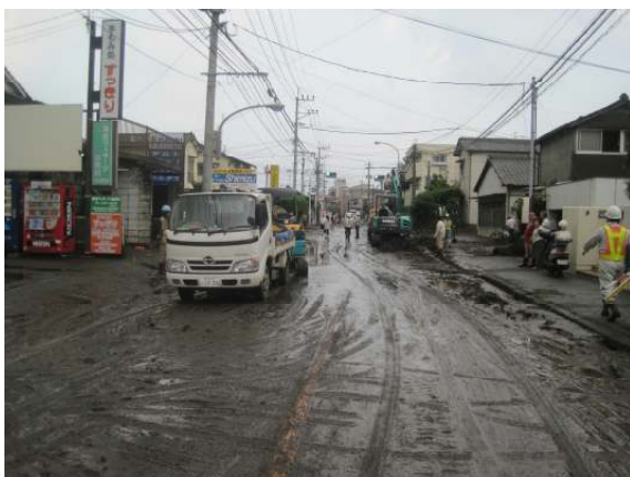
浸水した黒髪地区の県道337号(右岸側) 2012年7月12日撮影
