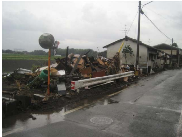
道路から2m近く浸水した吉原橋下流(右岸) 2012年7月22日撮影
