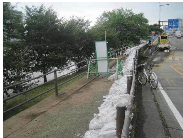
堤防が未着手で土のうが積まれた右岸側(国道3号) 2012年7月12日撮影
