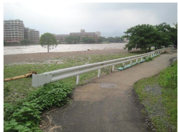
河道に大量の土砂がたまっている渡鹿堰周辺 2012年7月12日撮影
