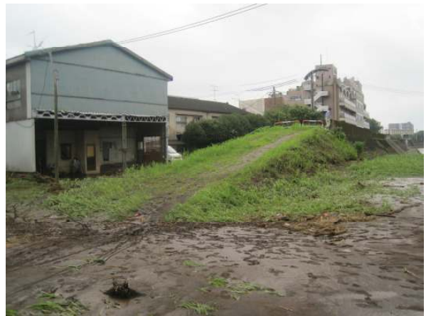
堤防が未完成の竜神橋下流の左岸から浸水 2012年7月12日撮影
