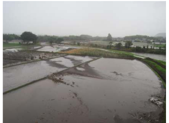
氾濫したはなぐり大橋上流 2012年7月22日撮影
