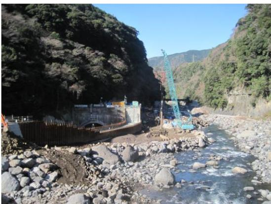
仮排水路トンネル工事と締切堤工事の状況。写真奥のV字谷がダム本体予定地。
