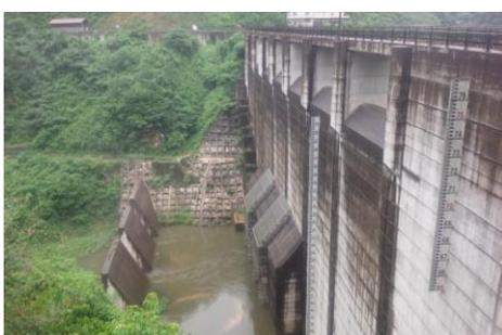
益田川ダム本体の上流側。流木対策として、上流側にコンクリートのつい立と、穴の上流をスクリーン(金網)で覆っている。
