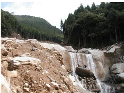
土石流により破壊され、基礎だけが残った砂防ダム(水俣市宝川内)
