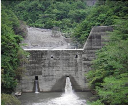
ダム下部の穴はふさがり、ダム中央部の穴から水が流れ落ちている朴木砂防ダム
