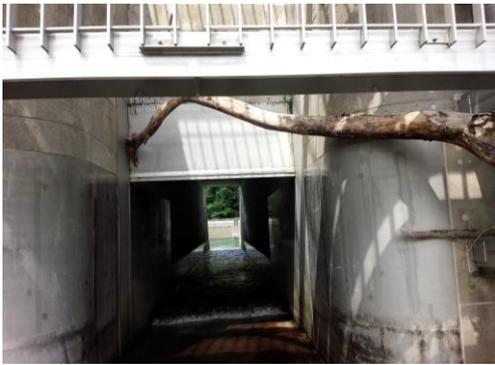
スクリーンの一部が水没した洪水の痕跡が見られ、スクリーンの内側に流木が引っかかっていた。
