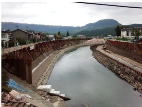
堤防の中に鋼矢板が打ち込まれている阿蘇・内牧の河川改修工事
