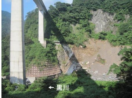
2012年7月洪水による地すべりで、長陽大橋下の旧道も崩落した
