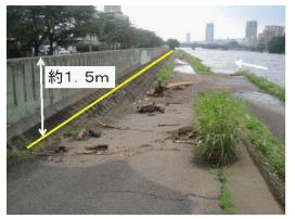
左岸(大学病院側)では堤防の上端から1.5m程度の余裕 (色が変わっている部分が最高水位の痕跡) 2012年7月12日16時53分撮影
