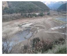
ダム湖の上流端付近に大量の土砂がたまった 球磨川上流の市房ダム(熊本県球磨郡水上村) 2012 年 1 月 2 日撮影
