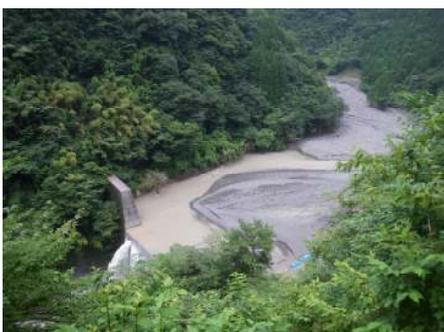
高さ25mのダムの上端まで土砂で埋まってしまった川辺川上流の朴ノ木砂防ダム(写真右側が上流)
