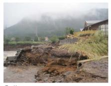
露天風呂まで浸水した岩戸温泉 コンクリート製の護岸もこわれている 2012 年 7 月 14 日撮影
