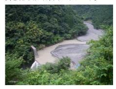
高さ25mのダムの上端まで土砂で埋まってしまった 川辺川上流の朴ノ木砂防ダム(写真右側が上流) 2012年7月16日撮影
