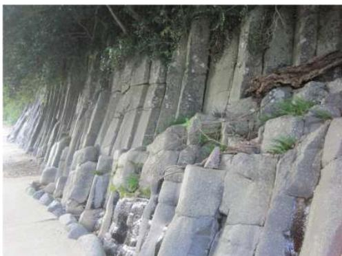
角材状の割れ目（柱状節理）が見られる立野ダム予定地の岩盤（右岸側）
