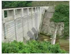
治水専用「穴あきダム」である益田川ダム(島根県) ダム本体の右側が上流側 2008年6月25日撮影 (出水晃氏提供)
