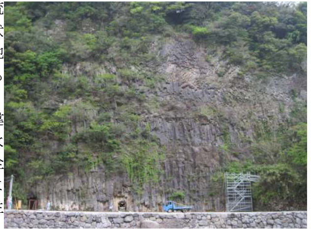
ダム本体予定地右岸側は柱状節理と板状節理が交互に堆積している 2014年4月19日撮影
