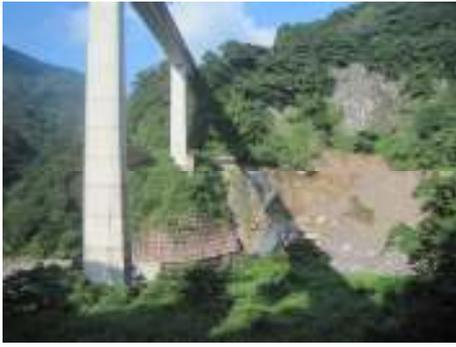
2012年7月洪水による地すべりで、長陽大橋下の旧道も崩落した
