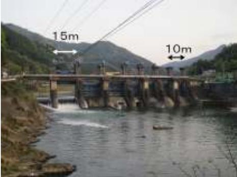
荒瀬ダムは写真右側から作りはじめ、ゲート間隔10mでは洪水時に流木が引っかったため、途中からゲート間隔15mと変更された
