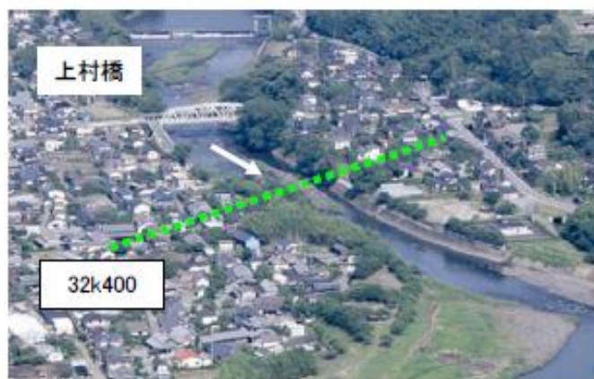
河道掘削イメージ
