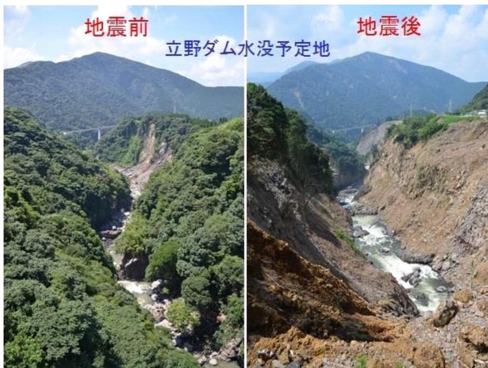
熊本地震前後の立野ダム水没予定地。黒川上流側から北向山方面を望む。奥に見えるのが長陽大橋。 これでは下りていく道路をつくることができないので、重機やダンプを下すことができない。 土砂の搬出や、土砂崩壊対策工事も不可能である。
