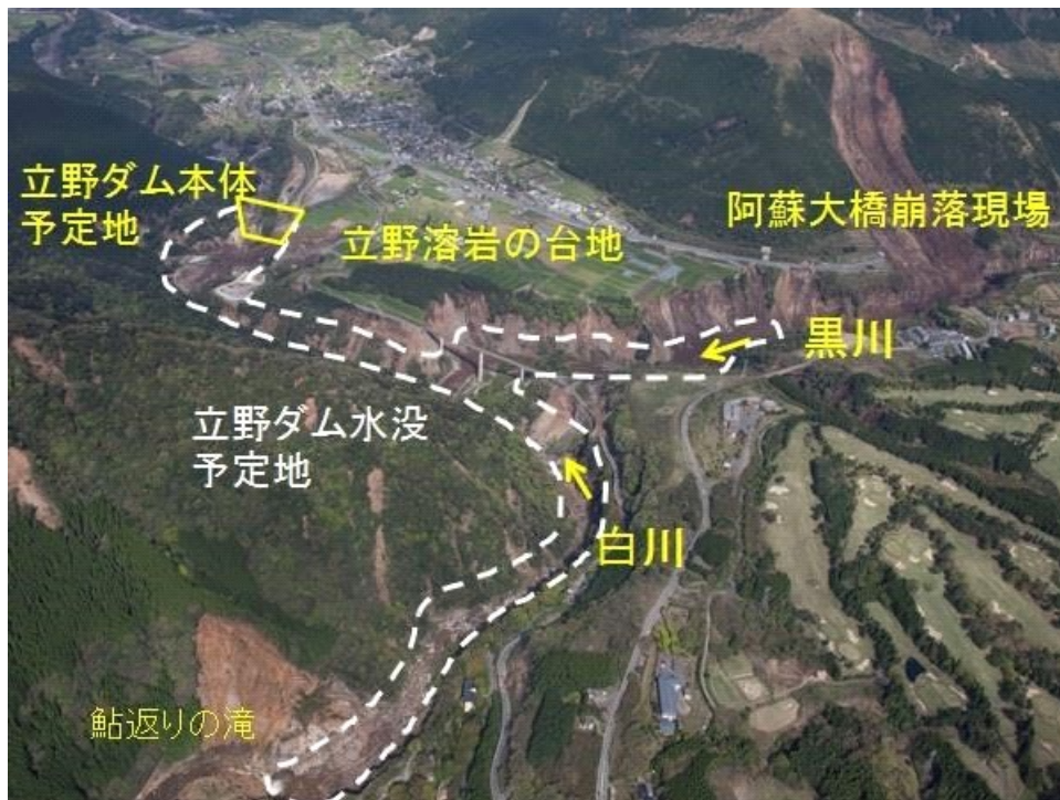
熊本地震後の立野ダム水没予定地。大半が土砂崩壊をしている。(パスコ航空写真に加筆) ダム水位が上がれば、立野溶岩の表面に堆積した火山性堆積物が崩れ、 湛水(たんすい)地すべりが発生するのは明らかである。
