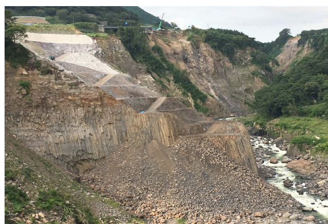
長陽大橋から見た破壊後の柱状節理 2017.8.30
