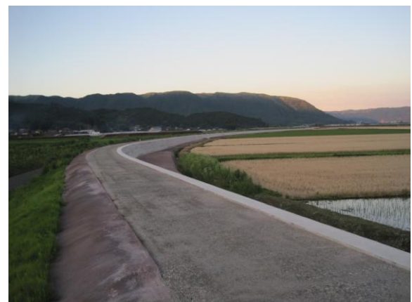
小倉遊水地(普段は水田として利用)を 囲む堤防(工事中) 2015.6.6 撮影
