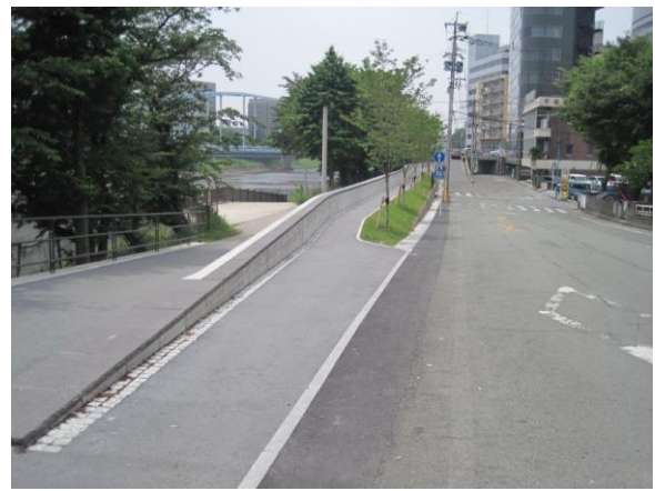
1年もたたずに改修が完成した同地点 堤防上端まで鋼矢板が入った壊れない堤防 2013年5月22日撮影
