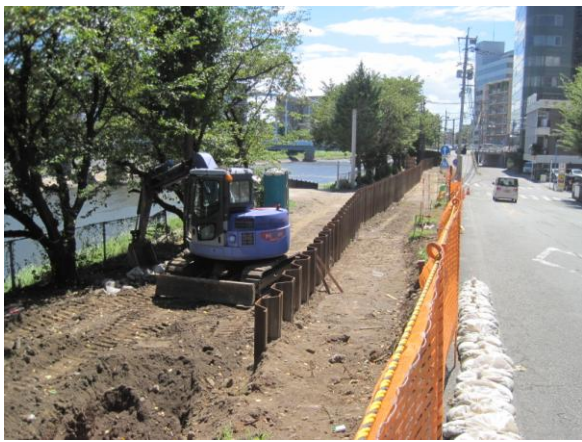
九州北部豪雨直後に堤防工事が始まり、鋼矢板が打ち込まれる大甲橋下流右岸 2012年8月25日撮影
