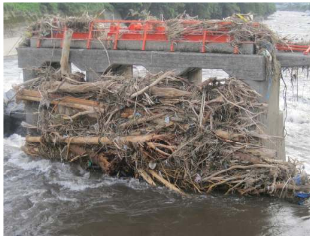
洪水時の流木でふさがった下井手取水堰（大津町） 立野ダムの「穴」もこのようにふさがってしまうことが 容易に想定できる 2012年7月15日撮影
