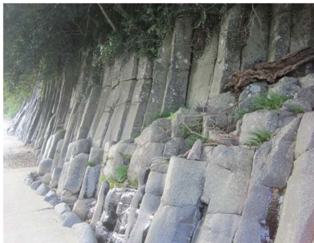
角材状の割れ目（柱状節理）が多く見られる 立野ダム予定地の岩盤（右岸側）
