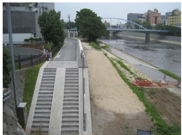
1年もたたずに改修が完成した同地点 堤防上端まで鋼矢板が入った壊れない堤防
