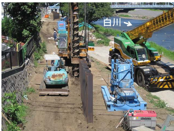
7・12 洪水直後に堤防工事が始まり、鋼矢板が打ち込まれる銀座橋上流右岸
