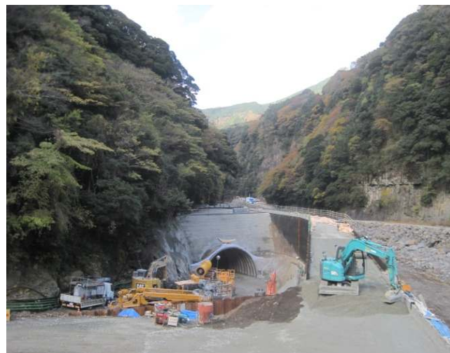
立野ダム仮排水路トンネル工事の状況。写真手前が上流側。奥のV字谷に立野ダムがつけようとしている 2014年11月22日撮影
