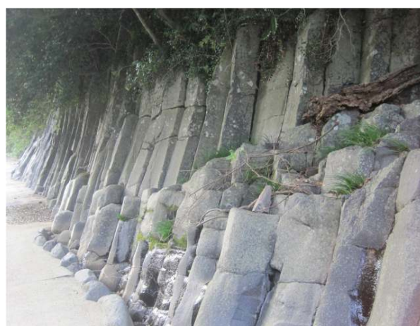
角材状の割れ目(柱状節理)が見られる 立野ダム本体予定地右岸側の立野溶岩
