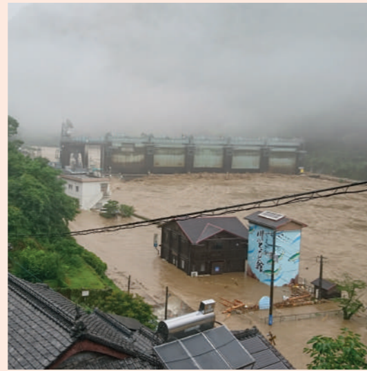
2020年7月4日球磨川豪雨時の瀬戸石ダム
