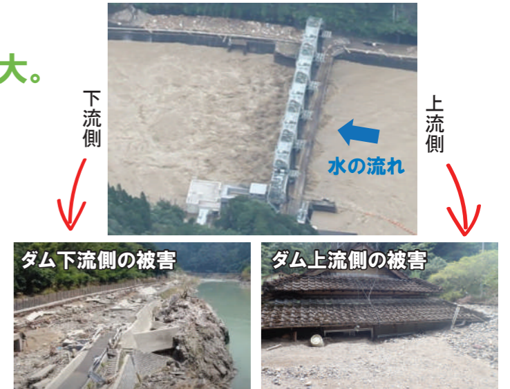
下流側ではすさまじい勢いで水が流れ、壊滅的被害が発生。上流側では徐々に水位が上がり、土砂が水平に堆積した
