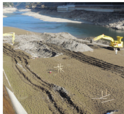
瀬戸石ダムは、国の検査で土砂堆積による危険性が指摘されてきた全国有数の「堆砂量が多い」ダム
