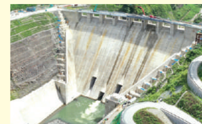
同じ流水型ダムである立野ダム。「流水型ダムだから清流も生態系にも影響はない」とは到底思えない。川辺川ダム貯水量はこの13倍以上。
