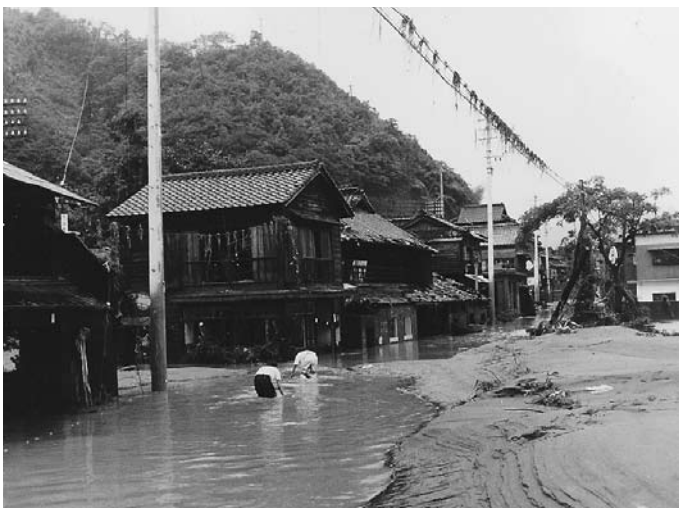
昭和40年7月3日の水害。水位が電線まできたことが分かる。堆積したヘドロは、ダム以外では説明がつかない
