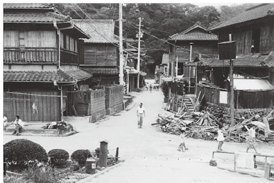
昭和40年7月3日水害後の坂本地区。一番の浸水地域だったが、村の中心地だった
