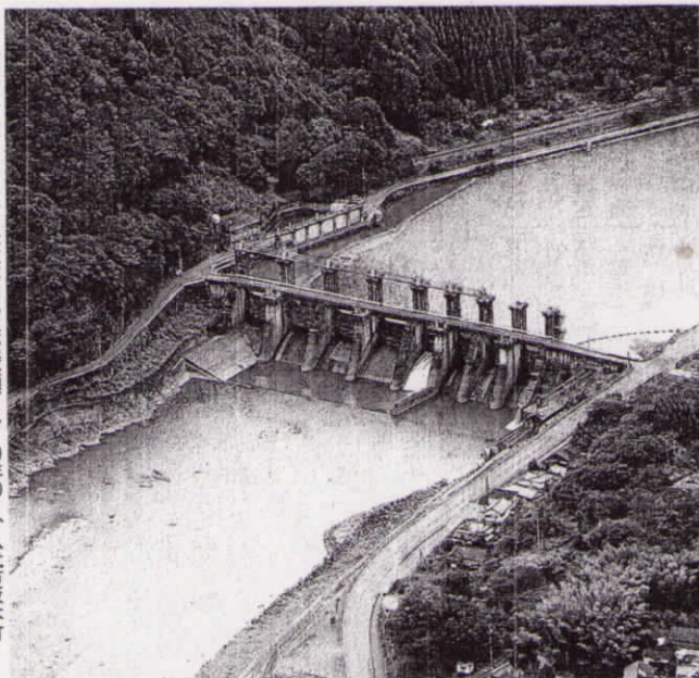
球磨川下流にある水力発電専用の県営荒瀬ダム。09年10月、八代市坂本町
