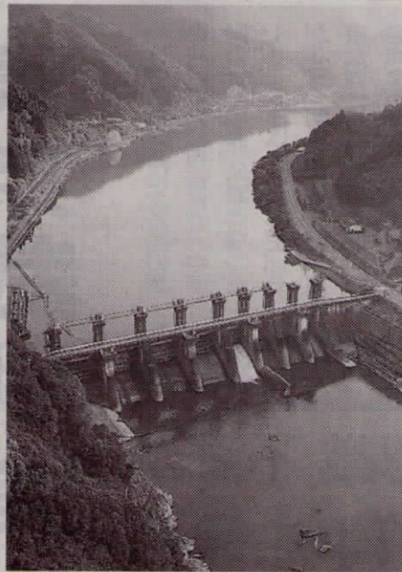
撤去が決まった県営荒瀬ダム＝熊本県八代市坂本町荒瀬、本社ヘリから、山本壮一郎撮影
