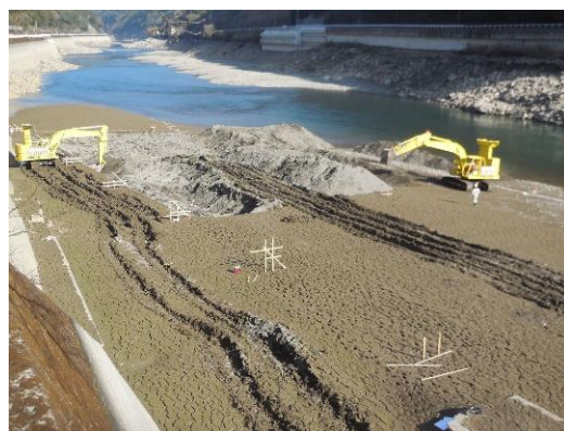
瀬戸石ダム湖での土砂撤去作業
