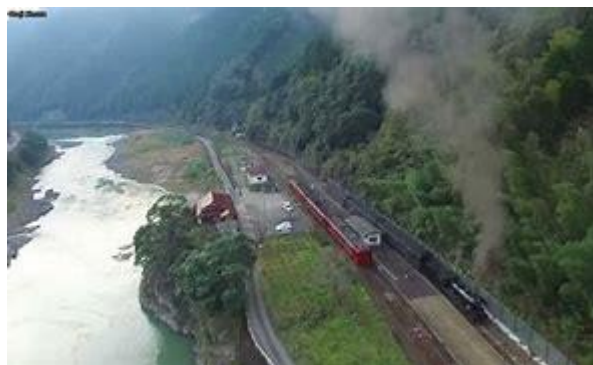
豪雨災害以前の JR 瀬戸石駅(下流から撮影)
