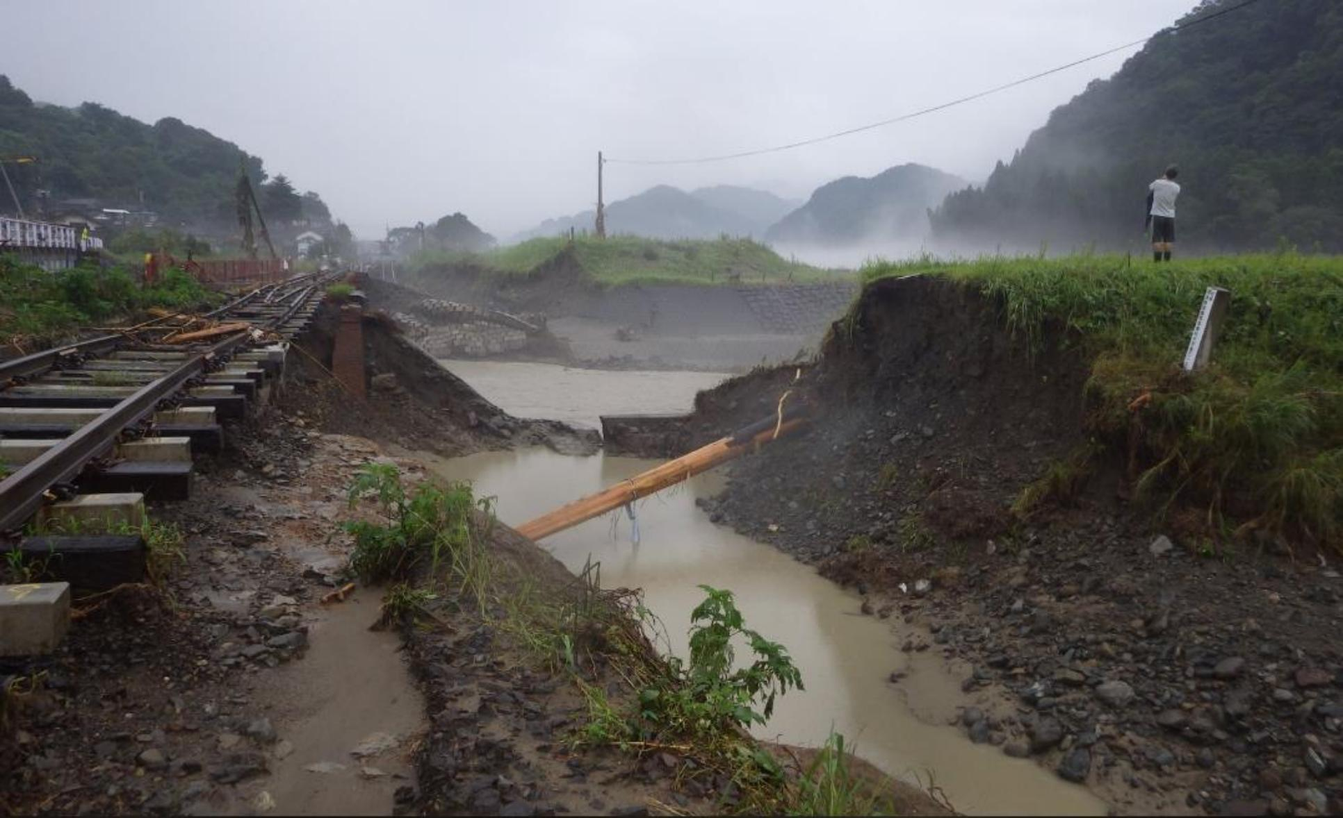
**球磨村渡で球磨川に合流する小川の破堤箇所（森明香・高知大助教撮影）
