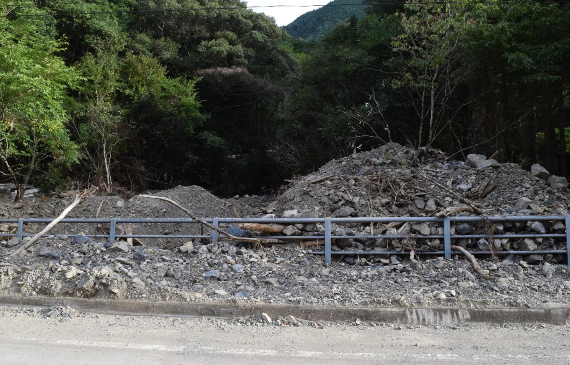
球磨村神瀬地区の竹の谷川の打ち出し口。土砂で完全に埋め尽くされている
