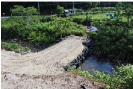
石木川に渡された工事用道路
