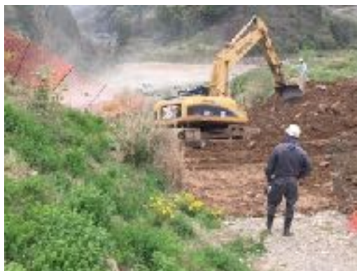
県道付替道路工事現場 (4月2日)
