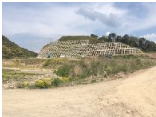
県道付替道路工事現場 (4月2日)
