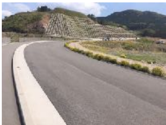
県道付替道路工事現場 (4月9日)
