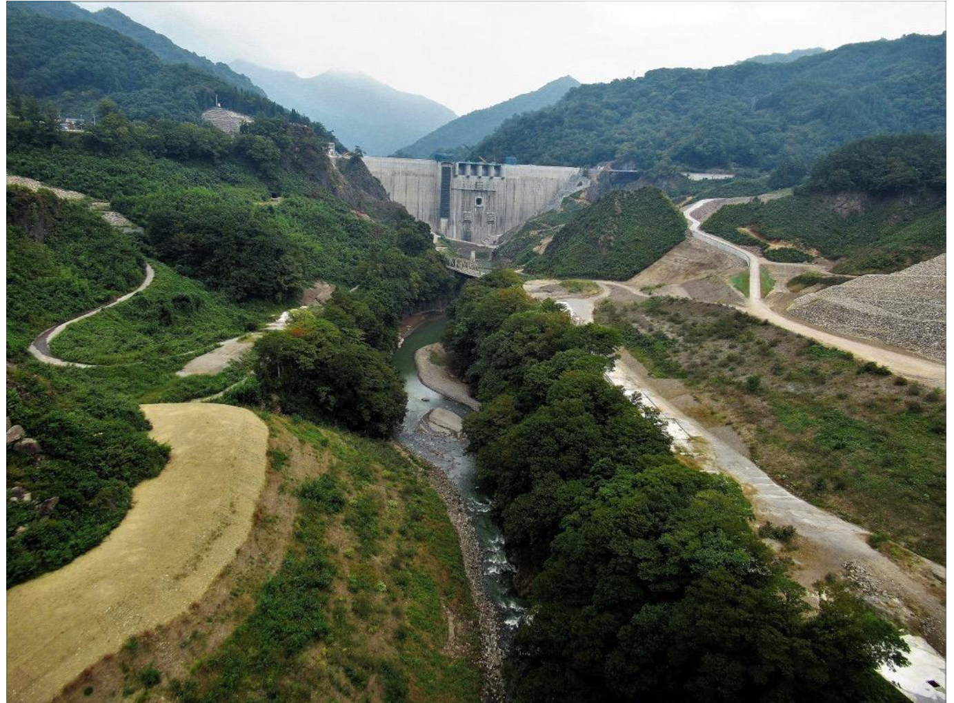
代替地の押さえ盛り土が吾妻川にせり出している。 2019年10月3日撮影
