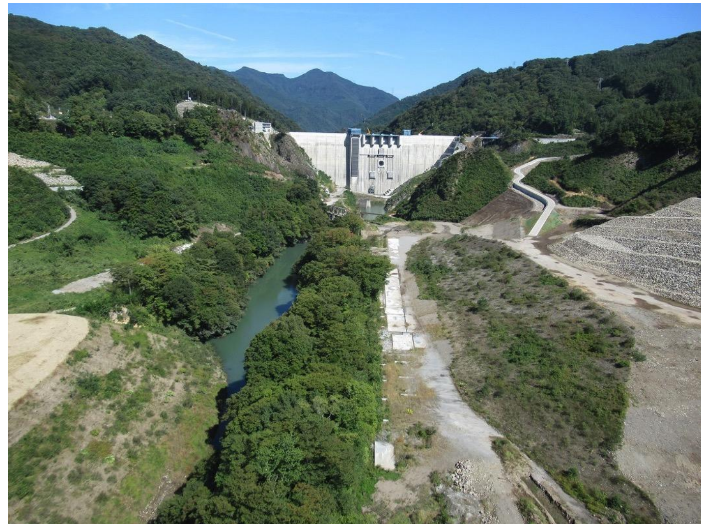
2019年10月10日撮影 両岸の代替地の押さえ盛り土、川原湯地区の線路跡
