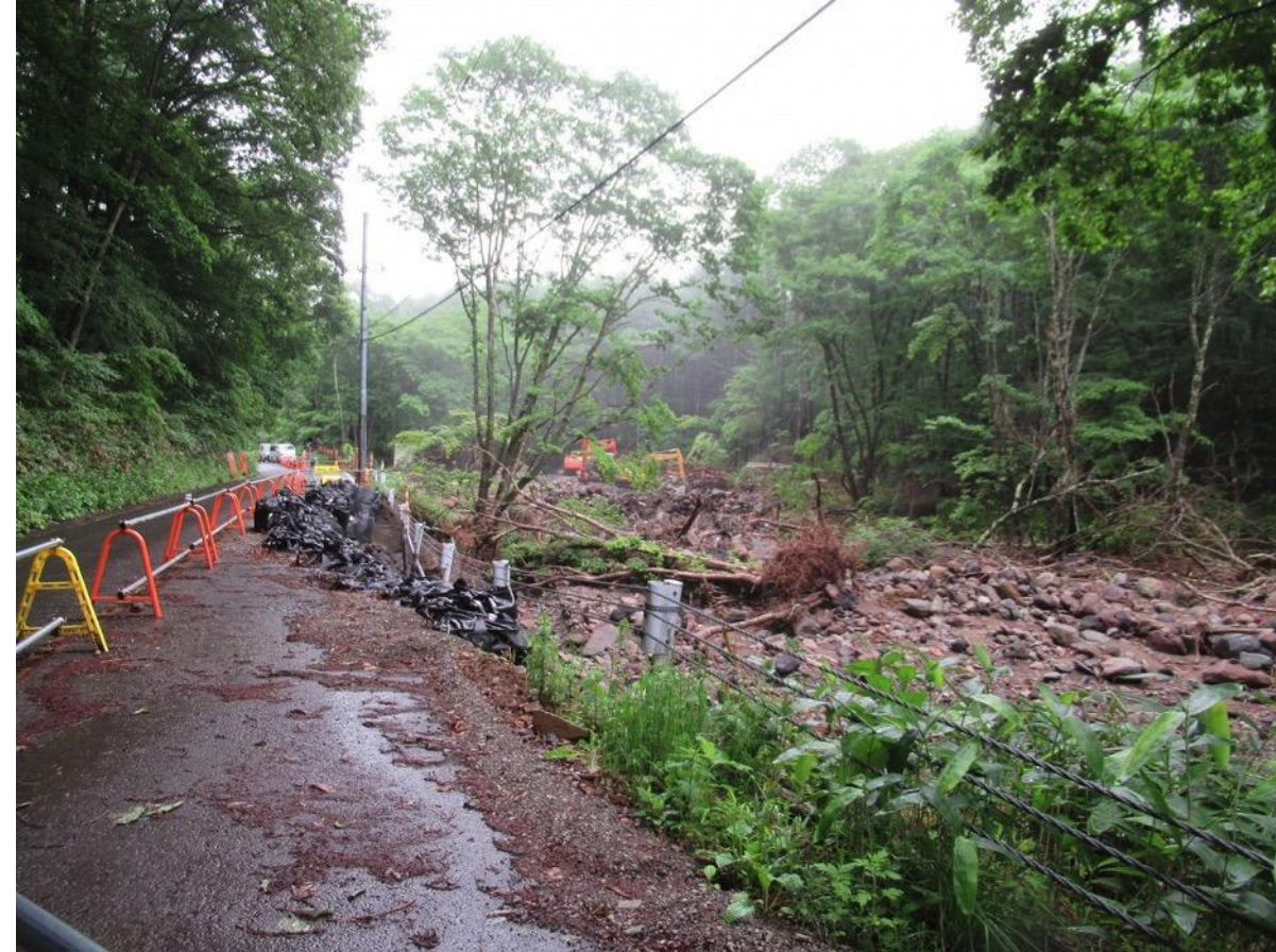
吾妻川の支流・湯尻川の災害復旧工事現場 群馬県嬭恋村 2020年7月4日
