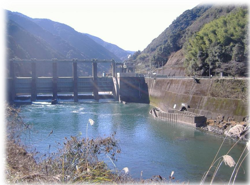
写真左：瀬戸石ダム
