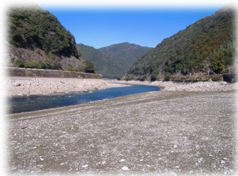
写真右：瀬戸石ダム上流 (ゲート開放時)
